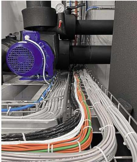
In den Kälte-Containern zum Transport von Impfstoffen müssen die Leitungen sowohl grosse Kälte von bis zu minus 100 °C als auch Hitze von bis zu 100 °C plus aushalten.
